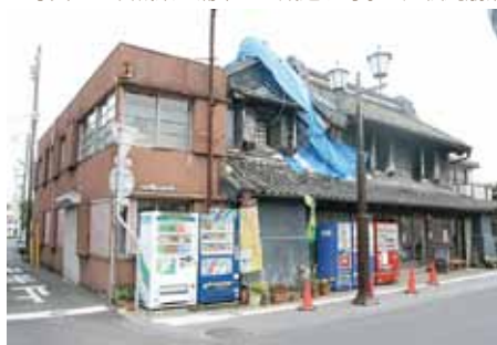
写真12 茨城県桜川市真壁 石造建物の妻壁崩落・下屋破壊[9-12 撮影:藤川昌樹]
