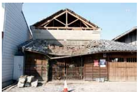
写真12 茨城県桜川市真壁 石造建物の妻壁崩落・下屋破壊[9-12 撮影:藤川昌樹]
