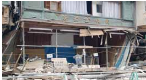
写真5 宮城県気仙沼市 1階部分が流失(津波被害) [4・5 撮影:野村俊一]
