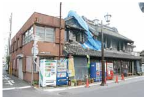
写真12 茨城県桜川市真壁 石造建物の妻壁崩落・下屋破壊[9-12 撮影:藤川昌樹]
