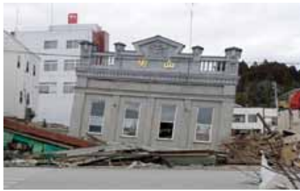
写真4 宮城県気仙沼市 1・2階部分が流失(津波被害)
