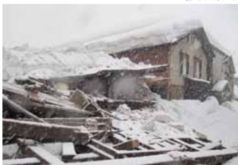
写真2 秋田県湯沢市 全壊(豪雪+地震) [提供:湯沢市]
