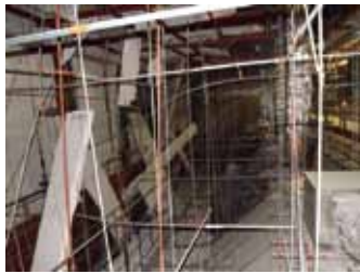
写真35 多賀城市文化センター天井裏
