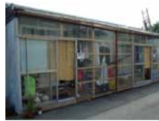
写真11 風除室の大型化(中越)
