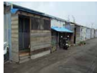
写真15 廃材の利用(中越)
