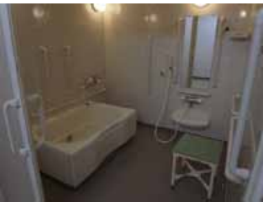
写真7 介助用の浴槽が設けられた浴室(事例1)
