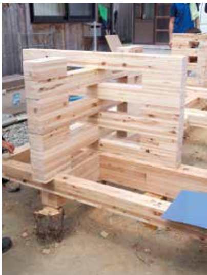
図3 木ブロックを積み上げた構法の柱
