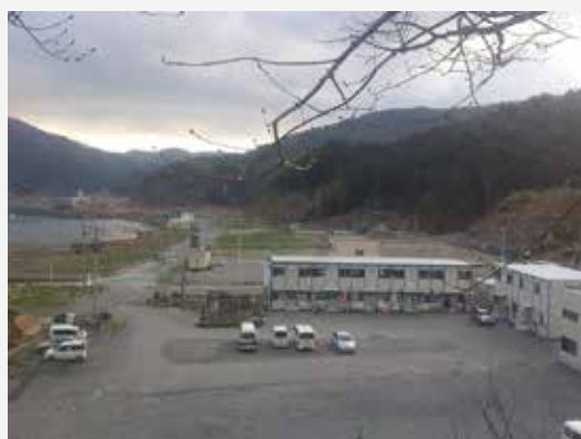
図1 石巻市雄勝町の中心部
