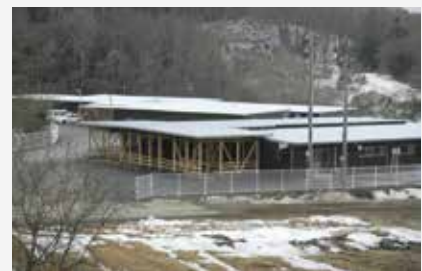
図1 グループホーム型仮設住宅
